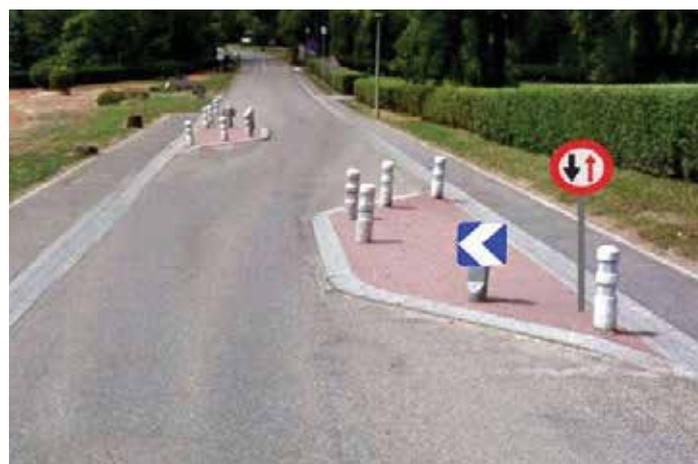
**Schéma type d'une double écluse**
